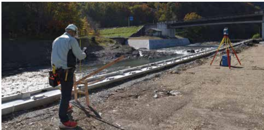
▲ データを作ってしまえば丁張りの作業が一人で簡単に出来る
